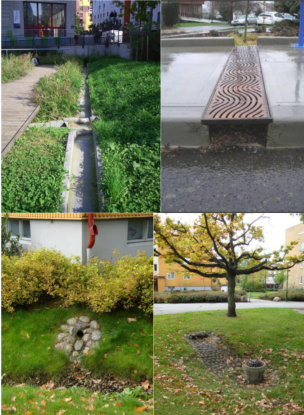
Figur 3 Övre bilder visar avledning i ränna samt släpp genom gångväg. Nedre bilder visar erosionsskydd vid dagvattenutlopp i parkmiljö.
