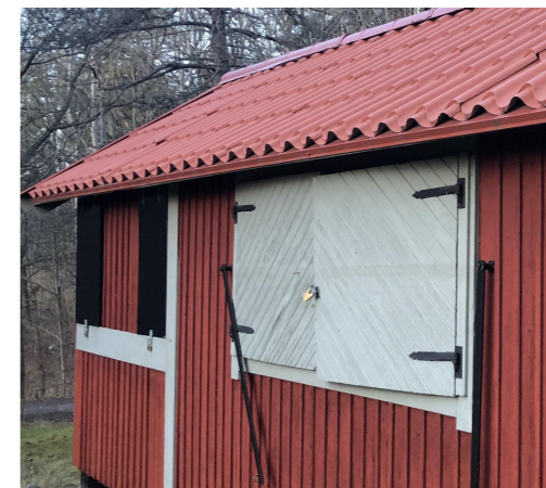
Fönsterluckor i Skuruparken
