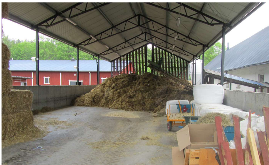
Figur 2. Den ca 320 m 2 stora gödselplattan vars höga kanter och tak skyddar mot nederbörd.
