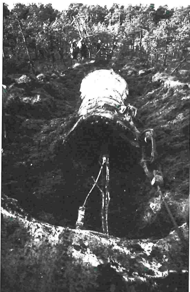
Förvriden masttopp med toppspiran längst bort
