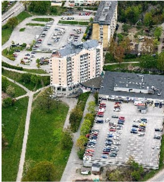
Parkeringsdäcken med garage under vid Älta Centrum.
