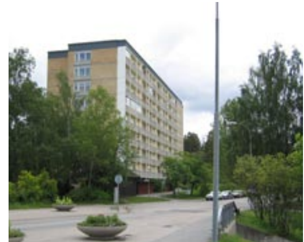
Ett av lamellhusen.
