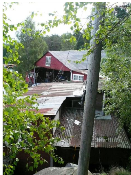
Verkstadens taklandskap avslöjar tillbyggnadsetapperna; sammanfogningen mellan olika byggnadsdelar samt med västra båthallen
