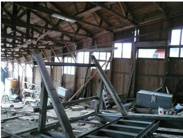
Ramverkskonstruktion, med fackverkstakstolar och stora fönstersystem. I byggnadens mitt, slipbanan Spännvidden i hallen är ca 12 meter
