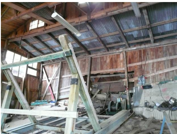
Gaveltillbyggnaden sett fr. insidan. Vajerspelet ligger i axel med slipen. Byggnaden är förankrad i gavelns betongplint
