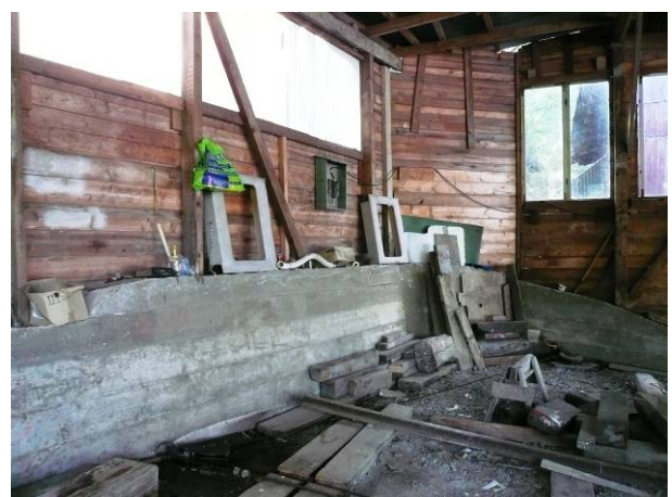
Betongplinten i höjd med södra gaveln; fr. O Hallens vajerspel är uppsatt utanför byggnaden
