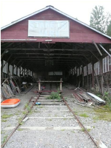
Östra hallen (K). Gavel och slip
