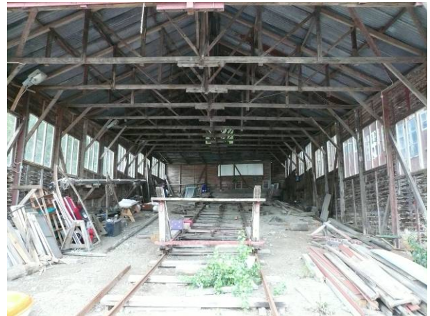
Hallen med slip; fr. N Spännvidden i hallen är ca 10 meter
