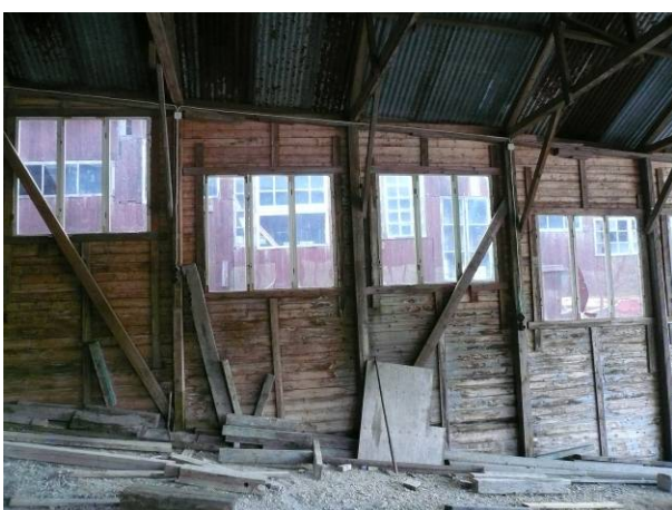
Östra hallen. Detalj av ramverkskonstruktionen; fr. O
