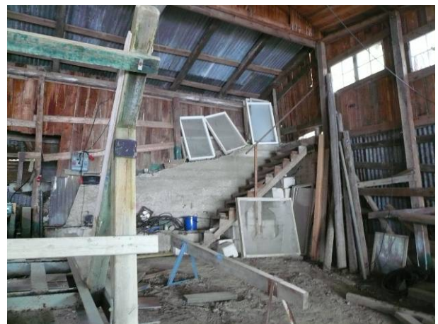
Ramverkskonstruktion, med fackverkstakstolar och stora fönstersystem. I byggnadens mitt, slipbanan Spännvidden i hallen är ca 12 meter
