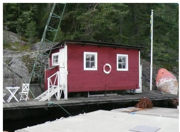
Övernattningsboden och mastkranen fr. N
