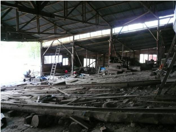
Västra hallen; mitt -och östra skeppet; fr. V
