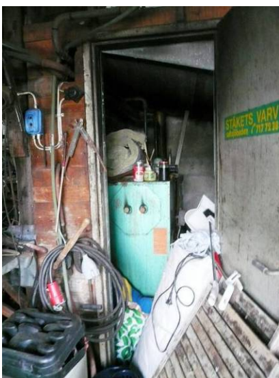
Östra delen av mekaniska verkstaden
