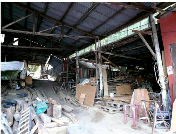
Västra hallen, med sideskeppets anslutning till verkstaden
