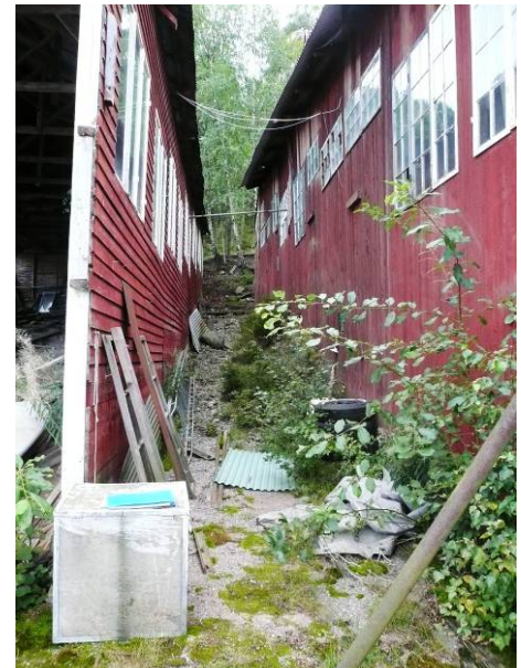
Prång mellan mitthallens (J) och Östra hallen (K); fr. SV
