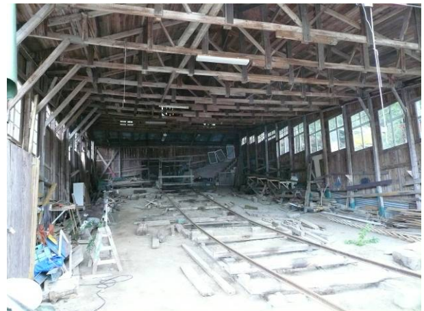
Ramverkskonstruktion, med fackverkstakstolar och stora fönstersystem. I byggnadens mitt, slipbanan Spännvidden i hallen är ca 12 meter
