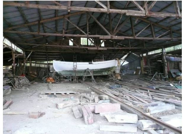
Västra hallen med sliprampen; fr. N Spännvidden i mittskeppet är ca 18 meter
