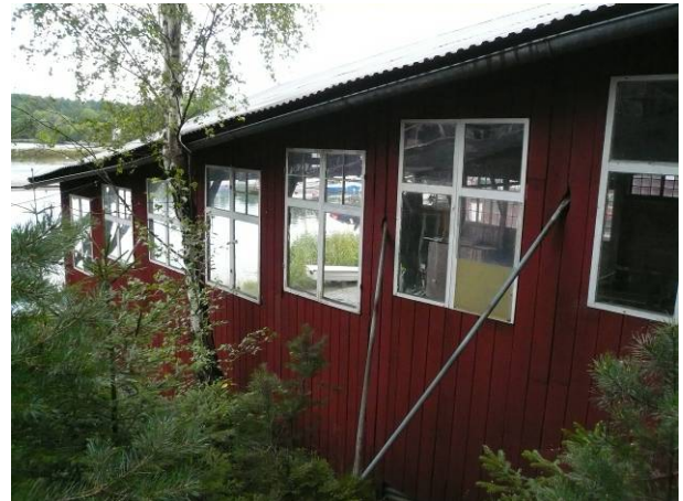
Fönsteruppsättning i västra långväggen, fr. SV
